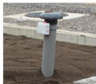
Fig-21 : Boîtier d'alarme
