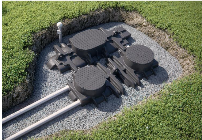
Fig-18 : Remblaiement
