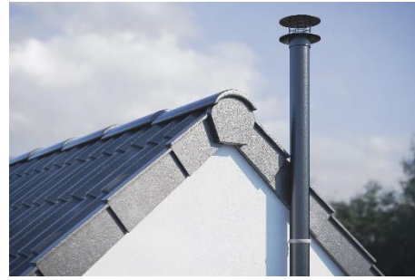
Fig-20 : Exemple de Ventilation haute
