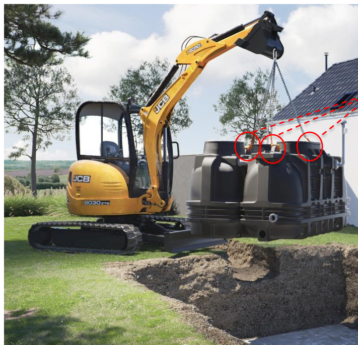
Fig-13 : Manutention de cuve
